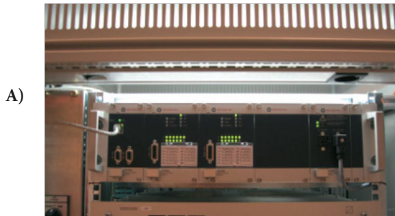
Şekil 3. Ünitelerde kurulu bulunan titreşim izleme sisteminin şematik gösterimi.
