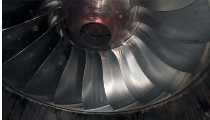
Şekil 12. Ünite çark kanatlarının emme borusundan çekilmiş fotoğrafı.
